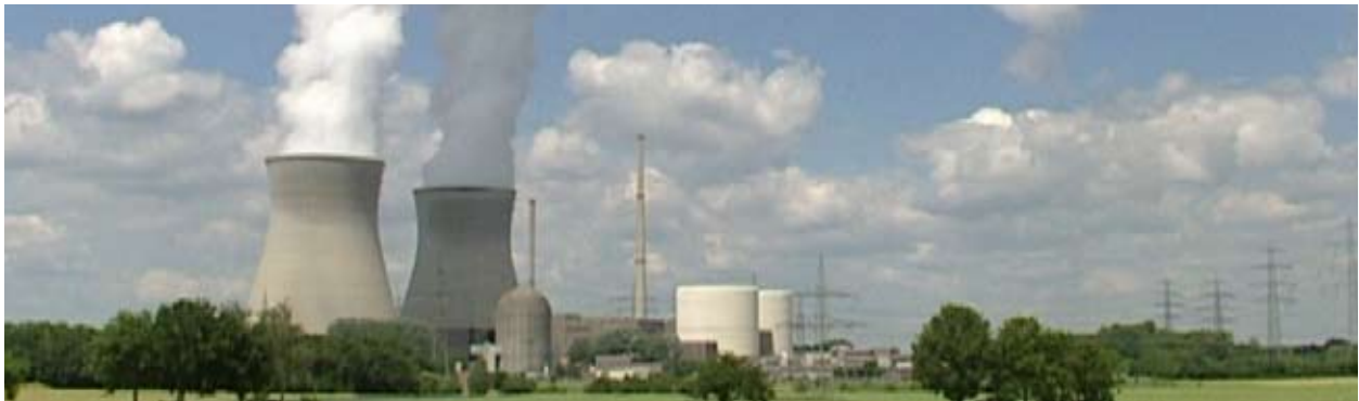
Gigantische Energieverschwendung: die Kühltürme eines Kernkraftwerkes
